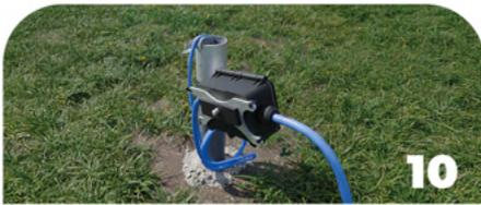
Posizionare il Patm (cassa nera) sull'elemento in acciaio inox, quindi fissarlo con 4 Rilsan.
