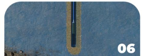
Abbassare la sonda in acciaio inossidabile nel tubo piezometrico fino al fondo, quindi sollevarla di 10-15 cm.
