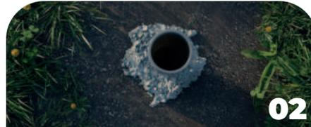
Ouvrez le bouchon et vérifiez l'état intérieur du tube en vous assurant qu'aucun obstacle ne soit présent.
