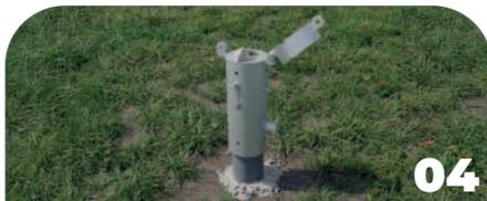
Installez le tube métallique sur le tube PVC et insérez les vis dans les trous prévus à cet effet.
